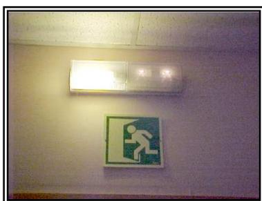
El alumbrado de emergencia es aquel que se activa automáticamente en caso de fallo del alumbrado general, permitiendo de esta forma la evacuación segura y fácil de los ocupantes del edificio hacia el exterior. Deberá poder funcionar durante un mínimo de una hora.
